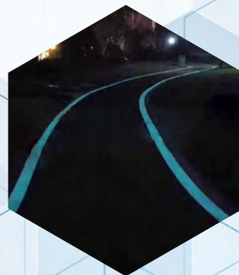
**Luminancia :** es el nivel de energía luminosa emitida por equipos fosforescentes (mcd / m<sup>2</sup>), catalogado según ISO17398 en varias clases C, D, E ...
